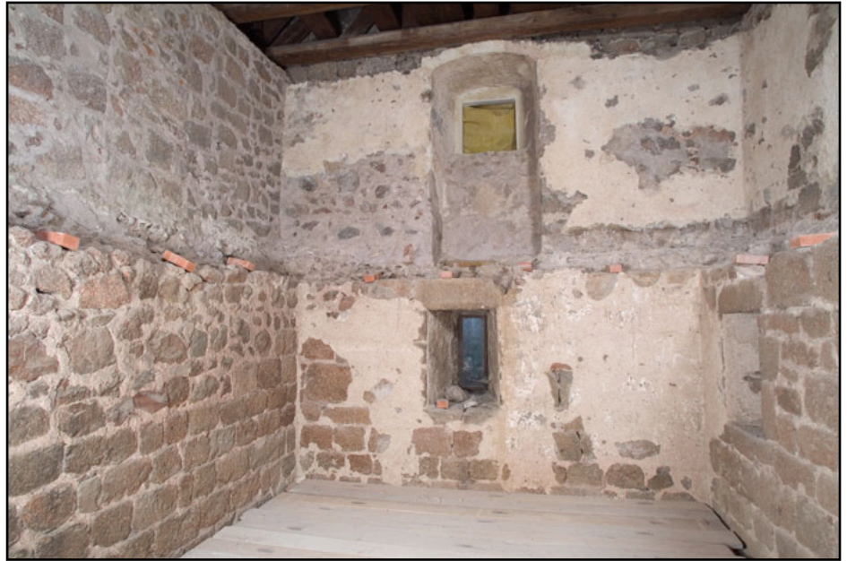
ABBILDUNG 4. Oberer großer Raum, Ebenen 1 und 2, Blick Richtung West: oberes Fenster neu geöffnet, mit historischem Sturz; ausgeführte Putz- und Fugensanierung; or Einbau der Galerie
