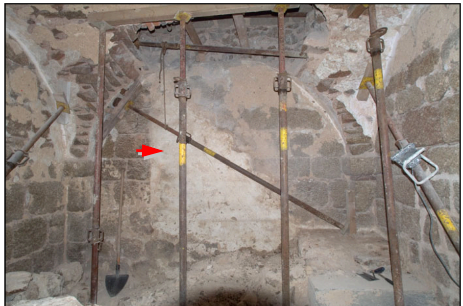
ABBILDUNG 5. Kapellenraum, Ebene 0, Westwand unterhalb der Empore mit rückgebautem Treppenblock, Putzfragment (siehe Pfeil) und aufgestemmter Treppenlauf-Öffnung
