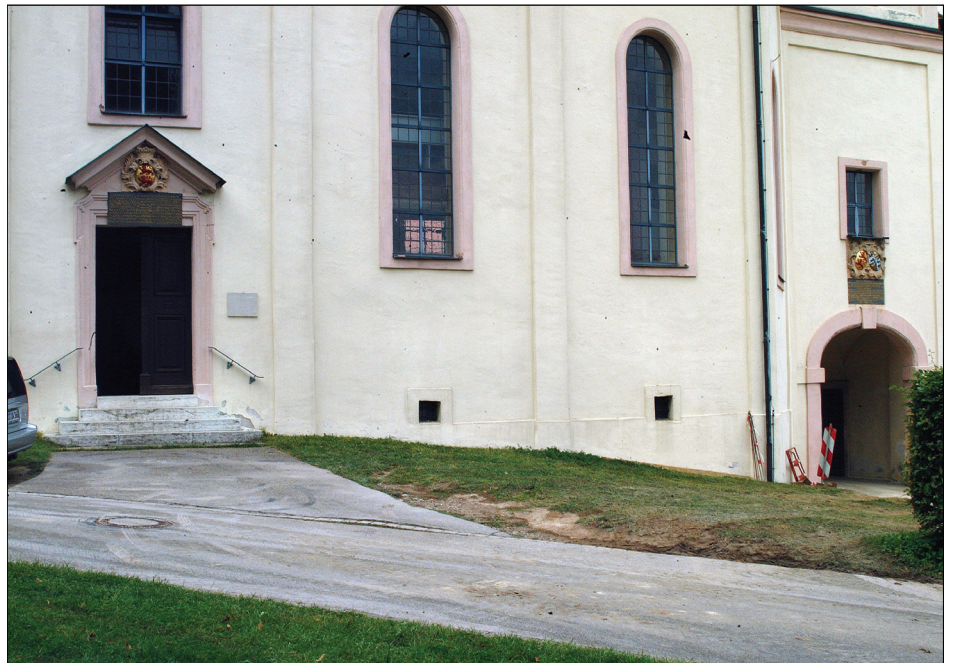
ABBILDUNG 2. Südfassade mit Lüftungsöffnungen der Gruft
